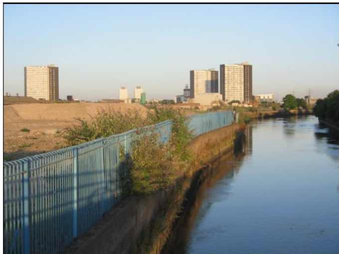
Figura 2. Obras de preparación villa olímpica River Lee. Stratford
